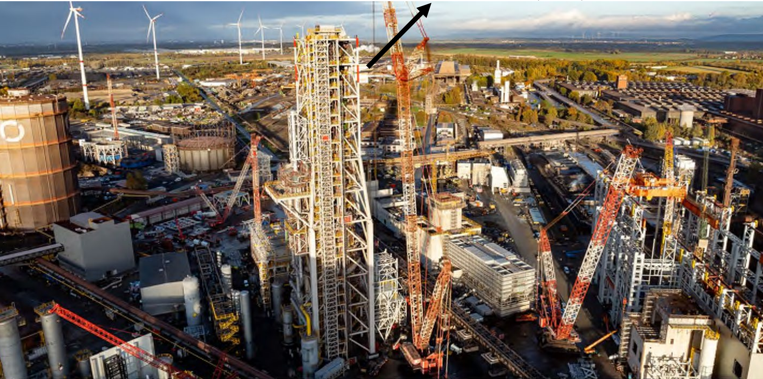
Das Baufeld September 2025: Veränderung durch den Aufbau der GreenSteel-Anlagen Direktreduktion-Turm (140 m)
